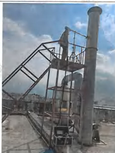
静电喷粉工序废气排放口
